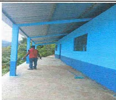
Foto 7: Mantenimiento de paredes exteriores aula de preprimaria y segundo primaria.
