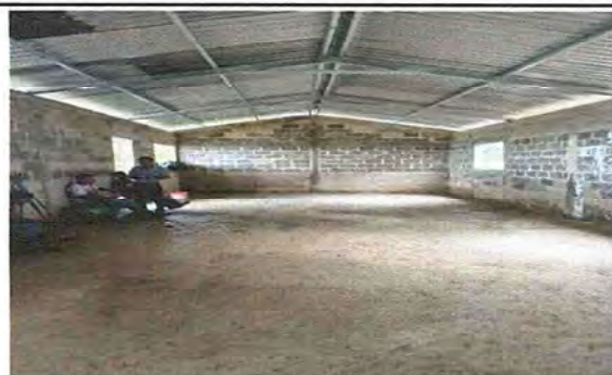
Foto 2: finalización de instalación de costaneras aula de preprimaria y segundo primaria.
