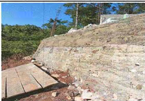
Foto 1: Finalización del muro de contención.
