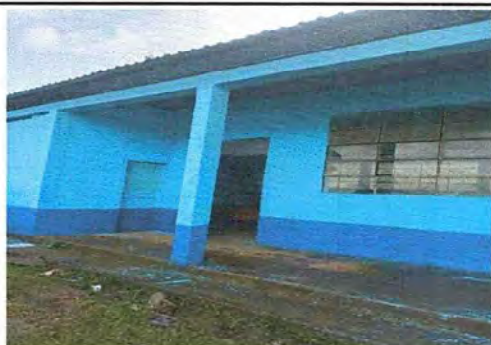
Foto 9: Mantenimiento de paredes interiores y exteriores aula de quinto y sexto primaria.
