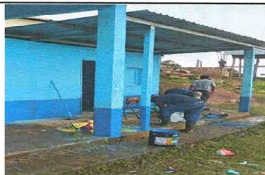
Foto 10: finalizacion de sustitucion de estructuras metalicas y mantenimiento de pared desde la direccion.
