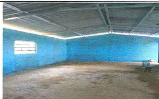
Fot 8. Finalizacion de sustitucion de estructuras metalicas y mantenimiento de paredes interiores aula de preprimaria y segundo primaria.
